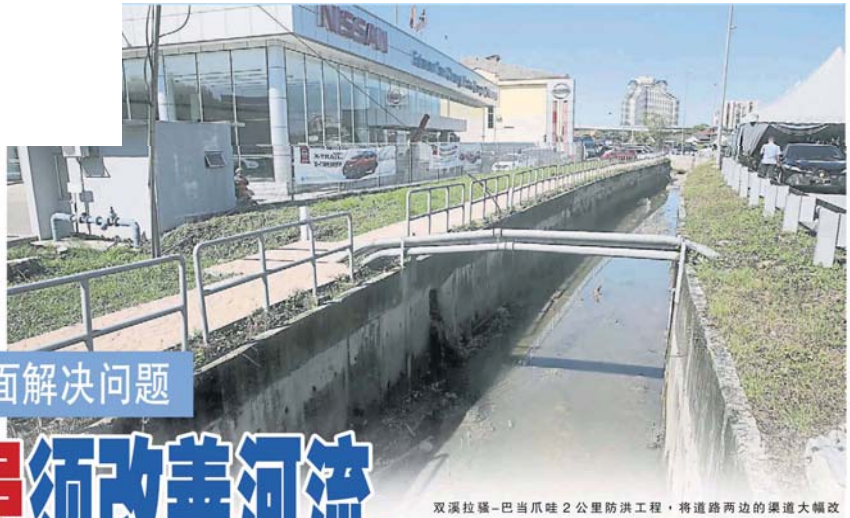
双溪拉骚-巴当爪哇2公里防洪工程，将道路两边的渠道大幅改善，以便解决该区排水问题。
