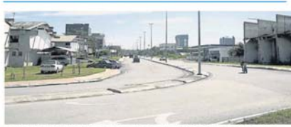
巴当爪哇在提升道路工程完成后，也改善当地路淹水问题。
